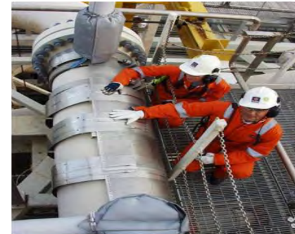
ProMix (séparation du brut)
